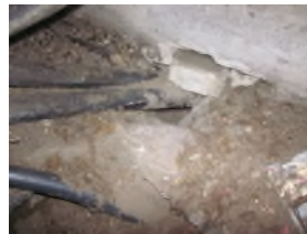
Verschließen von Rattenwegen z. B. Kabelkanäle
