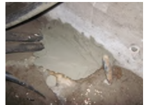
Verschließen von Rattenwegen z. B. Kabelkanäle
