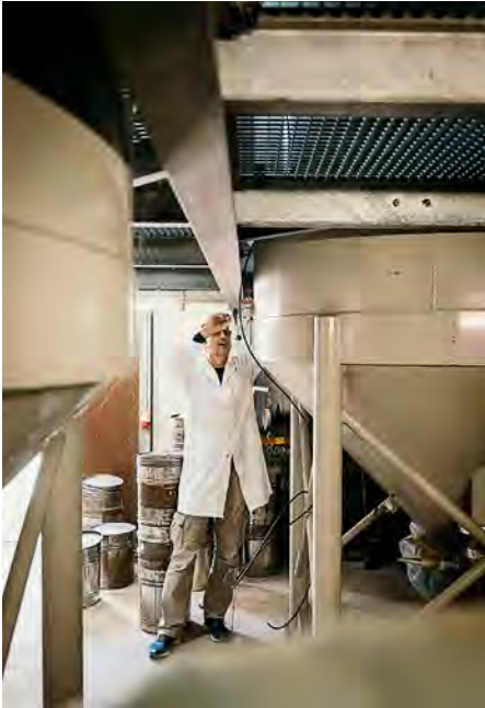
Auf dem Institutsgelände: Am Zementsilo, das seit den 1980er-Jahren zur Getreidelagerung genutzt wird, entnimmt Dr. Adler mit einer Spritze eine Luftprobe, um den Sauerstoffgehalt im Inneren zu prüfen – entscheidend für den hermetischen Vorratsschutz.
