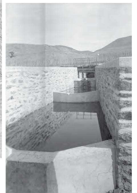
Weitere Typen von Spritzbrühemischanlagen. Gr. Bild: Holzgerüst mit Holzfässern an Weinbergsmauer gelehnt. Kl. Bild: Spritzbrüheanlage aus Beton bei Bad Kreuznach.
