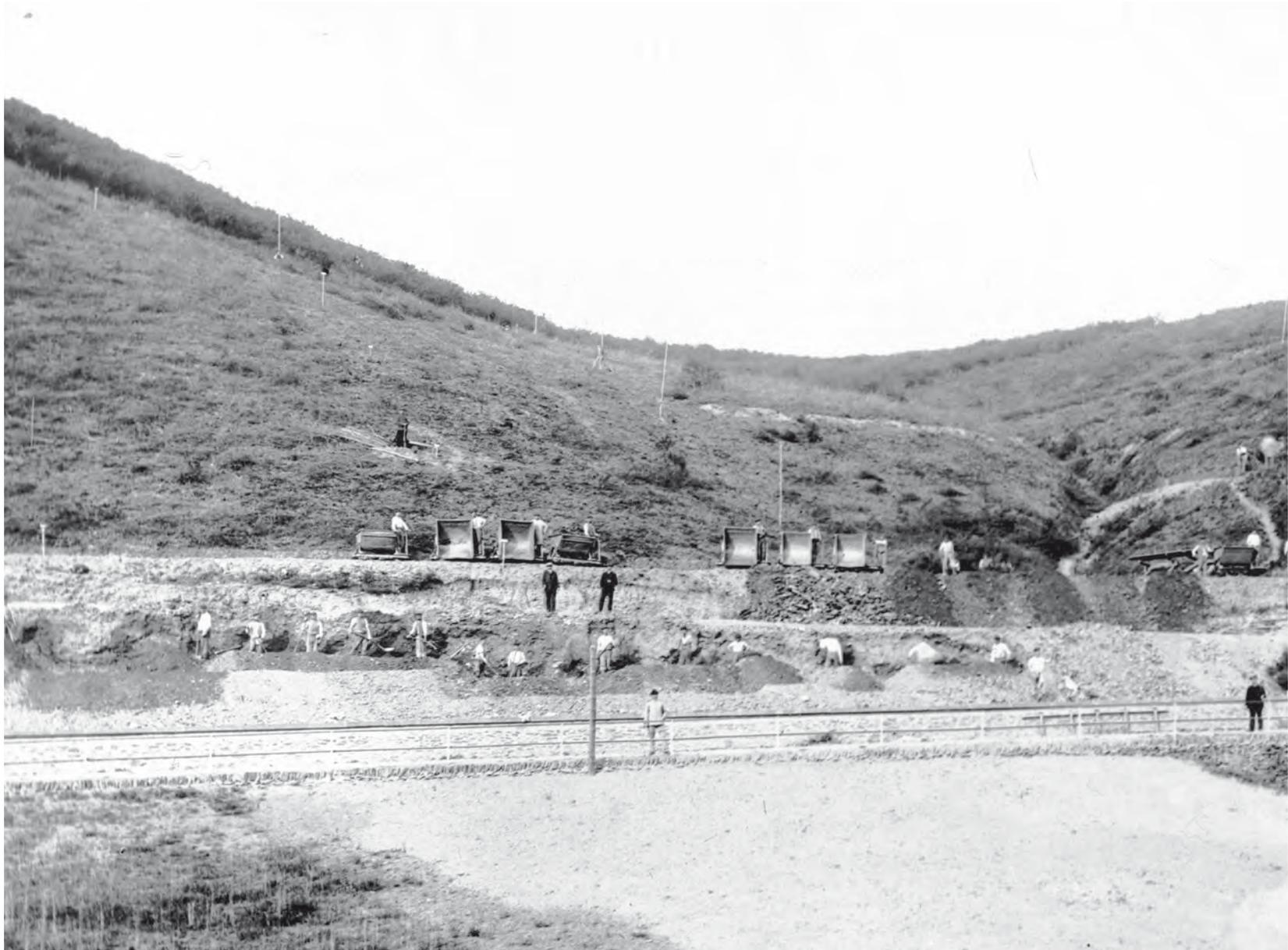
Bodenbearbeitung per Seilzug und Feldbahn. Ein Vorläufer der heutigen Steillagenmechanisierungsgeräte SMS oder RMS.
