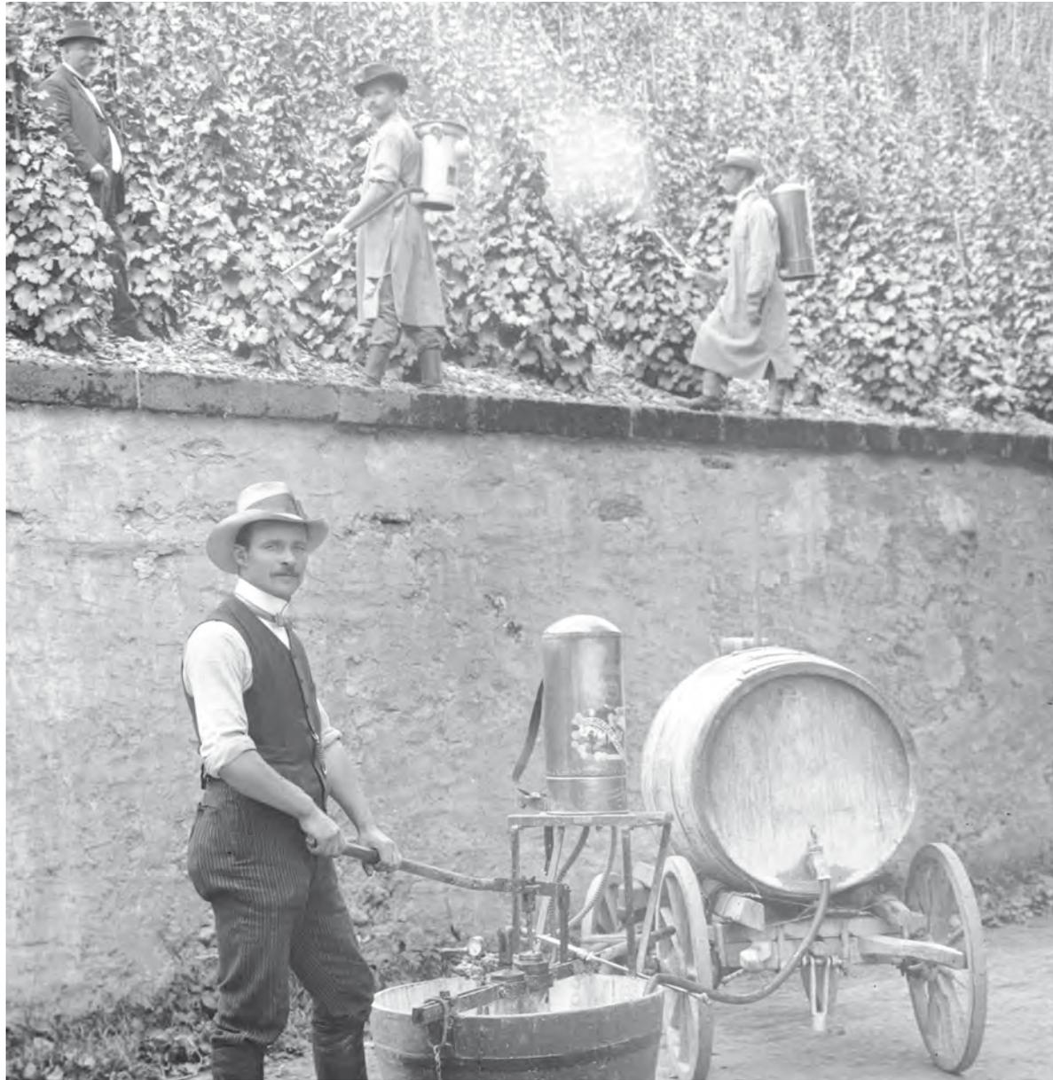
Batteriespritzen im Einsatz. Batteriespritzen sind Spritzen, die keine eigene Pumpe haben und mit einem Grunddruck von 3 Bar befüllt werden, bevor die Spritzbrühe zugegeben wird. Dieser Grunddruck bleibt auch im geleerten Behälter erhalten und wird für die nächste Füllung mit Spritzbrühe wiederverwendet.
