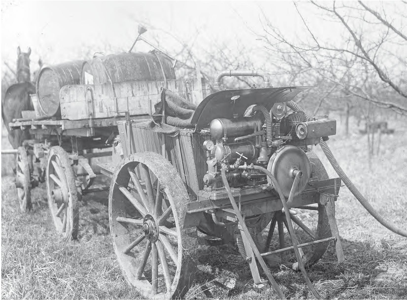
Zweiachser Motorbaumspritze der Firma Platz mit integriertem Brühebehälter
